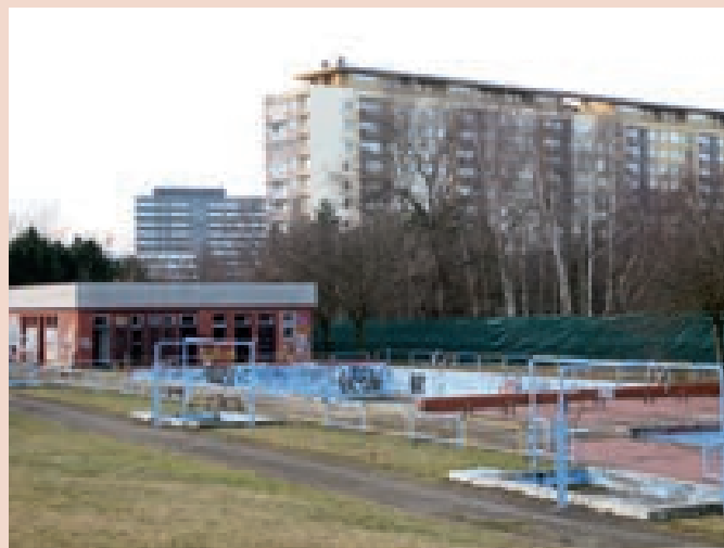
Na bývalém koupališti se již rozjíždějí stavební práce
